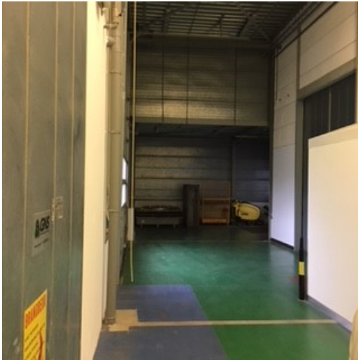
Corridor load dock naar unit 2
